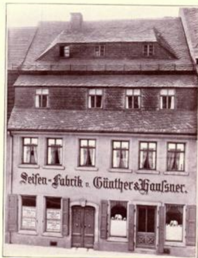
Gründungsbaus der Firma (äußere Johannisstraße 26).
