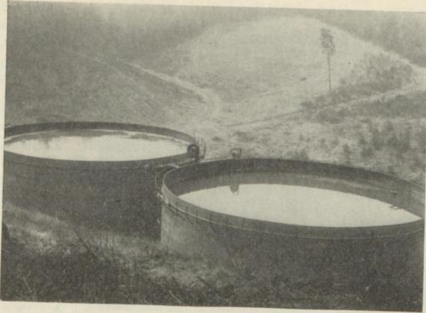
Bild 6. Stapeltanks mit je 6000 m 3 Inhalt an einer Zwischenpumpstation
