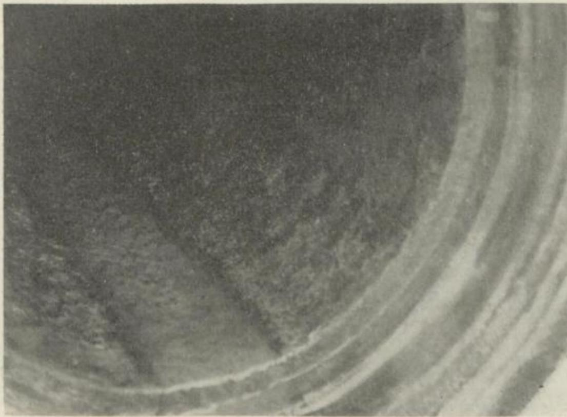
Bild 10. Innenfläche der gereinigten Gußrohrleitung
