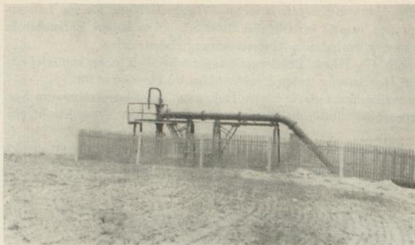
Bild 12. Aufbau eines Brunnenkopfes
