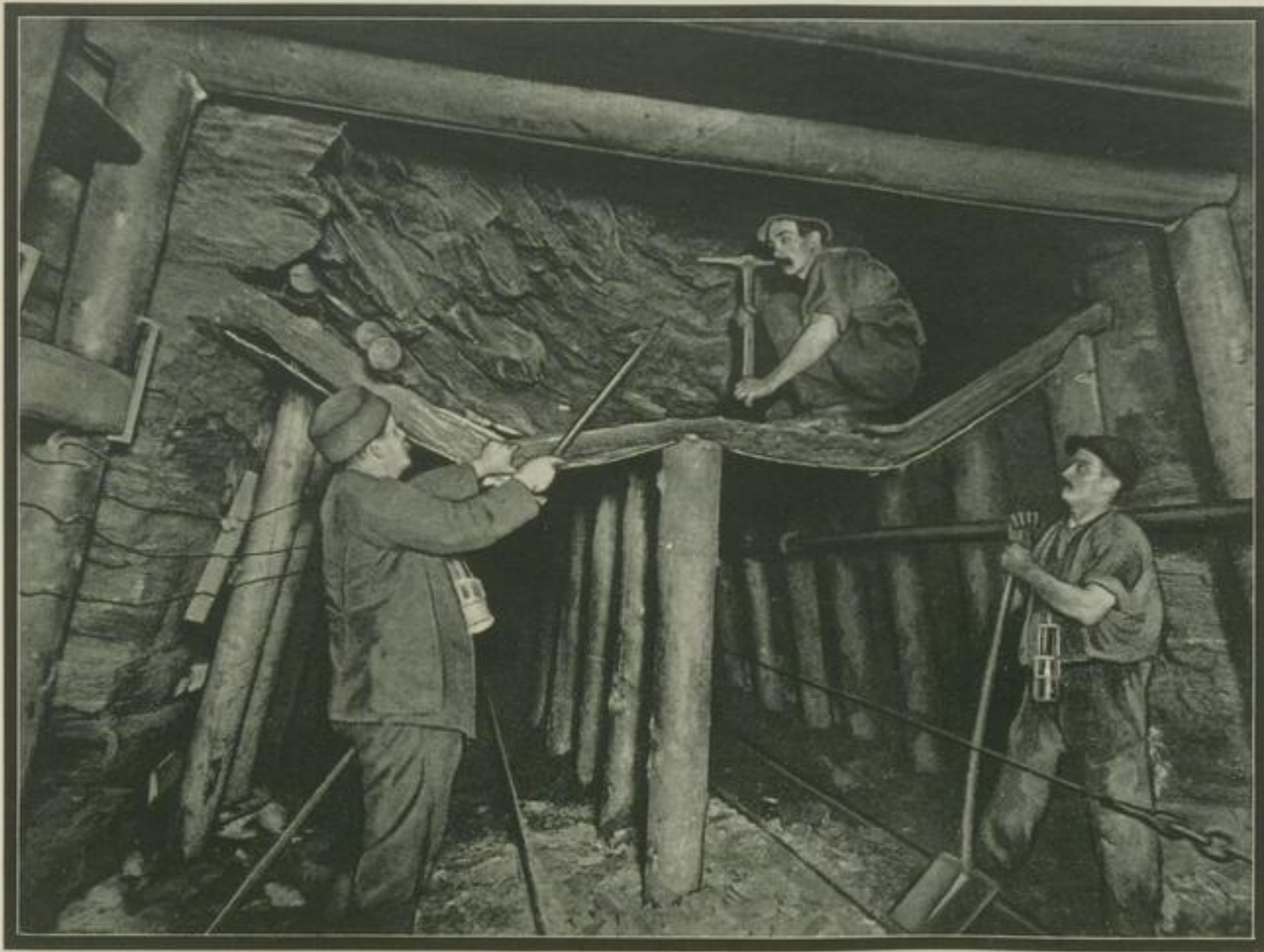
Beim Nachfirsten zerdrückter Förderstrecken.
