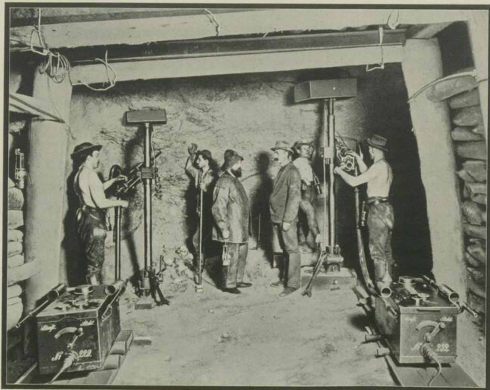
Solenoid-Stoßbohrmaschinen der Firma Siemens & Halske aus dem Jahre 1900.
