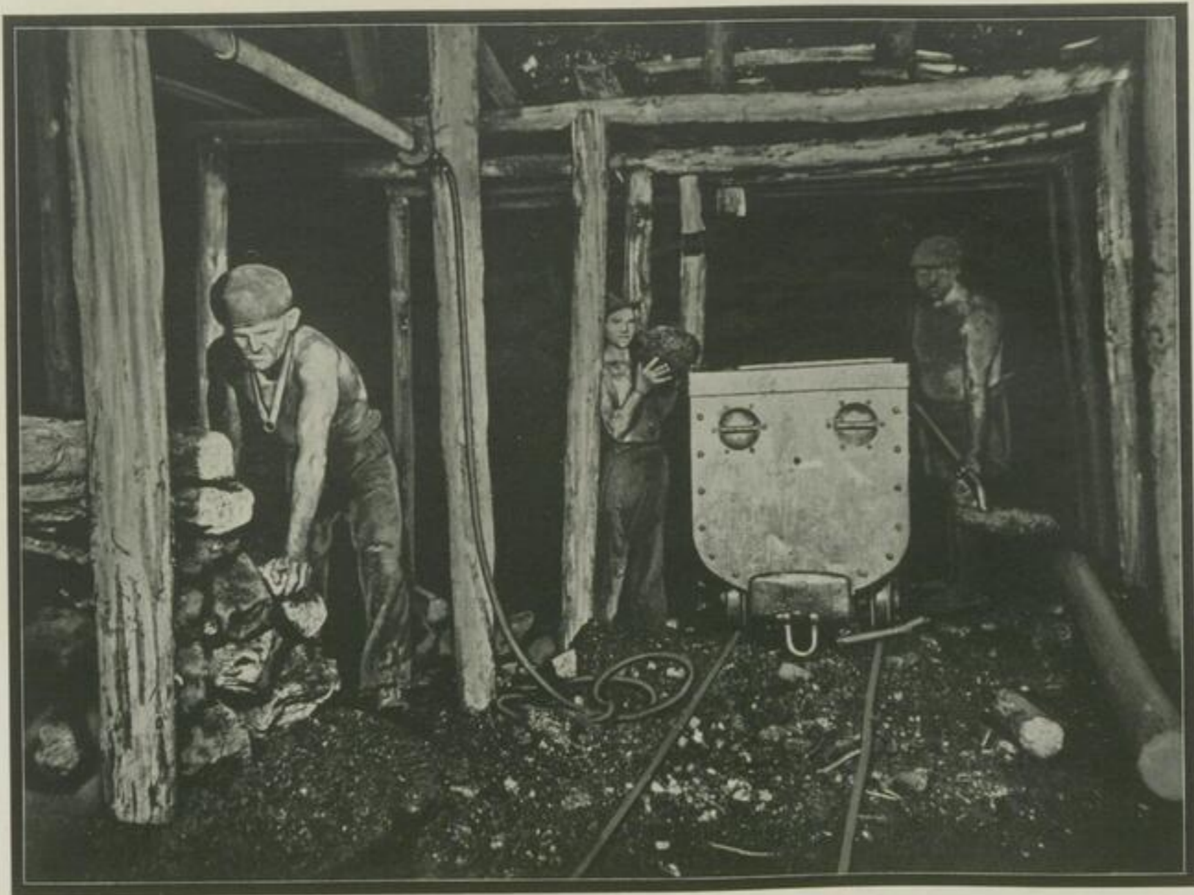
Stoßbau mit Handversatz.
