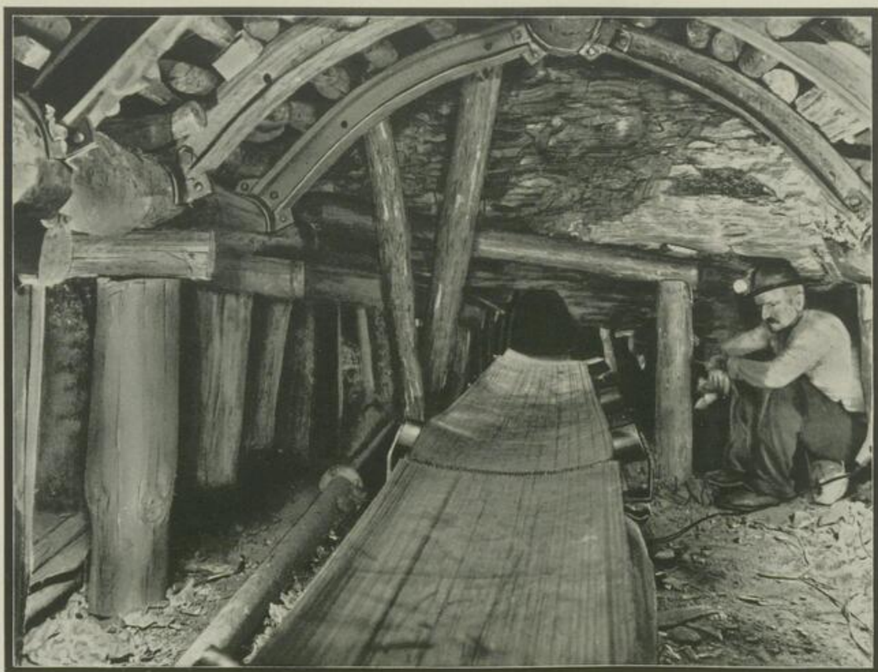
Gummibandförderer in niedrigem Streb.
