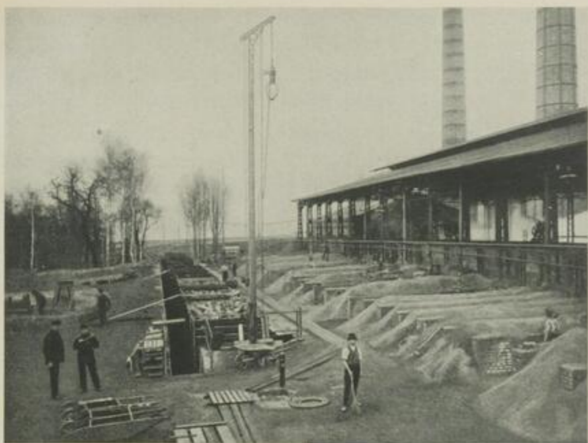
Alte Kokerei der von Arnimschen Stein- kohlenwerke in Planitz.
