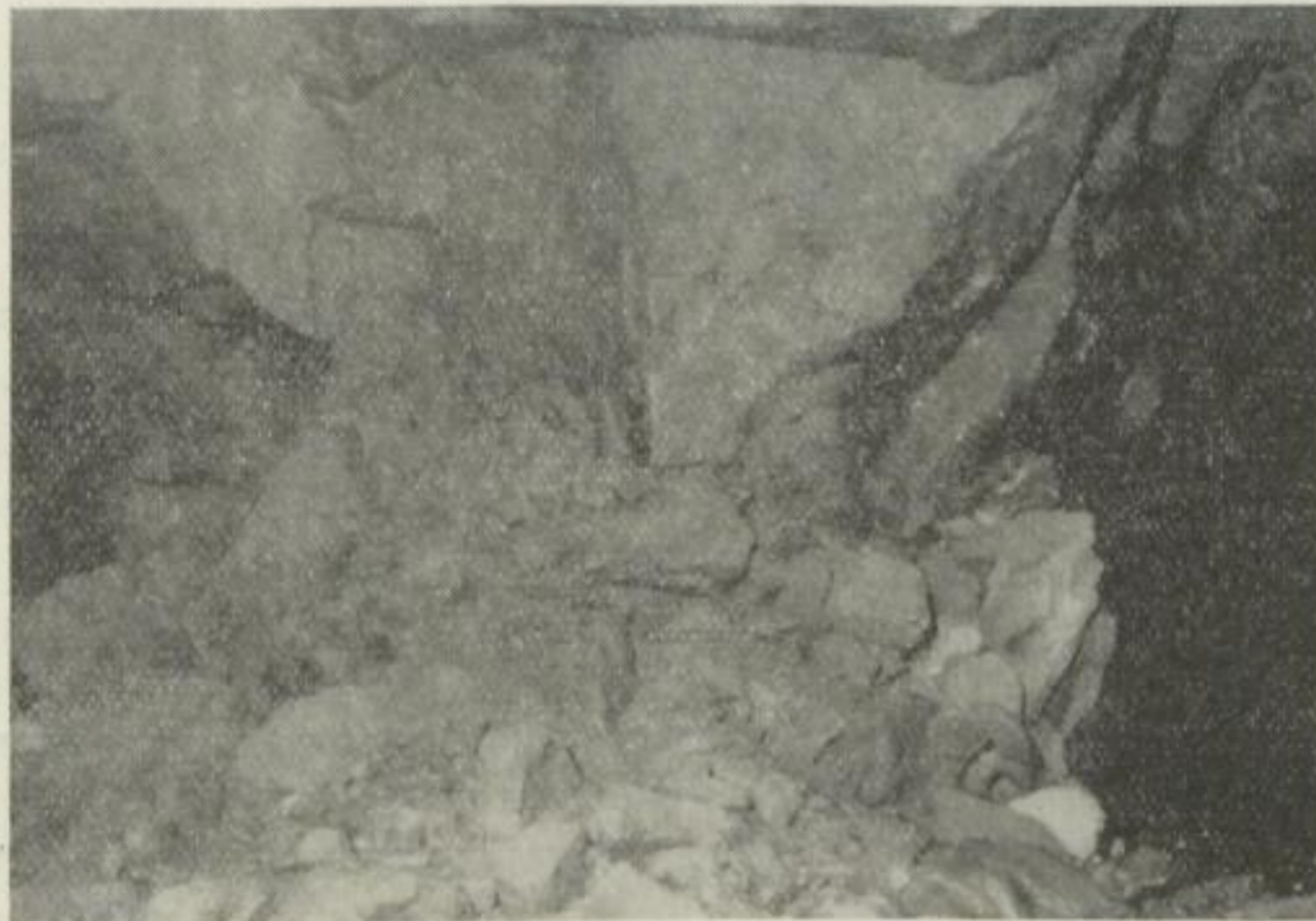
Abb. 15. Typische doppelkegelförmige Zerstörungsform im Abbau 333
