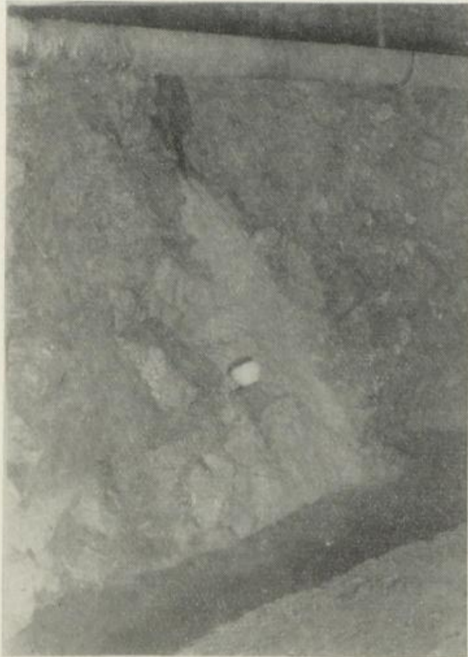
Abb. 2. Wasserführende Kluft (4. Sohle Ost)
