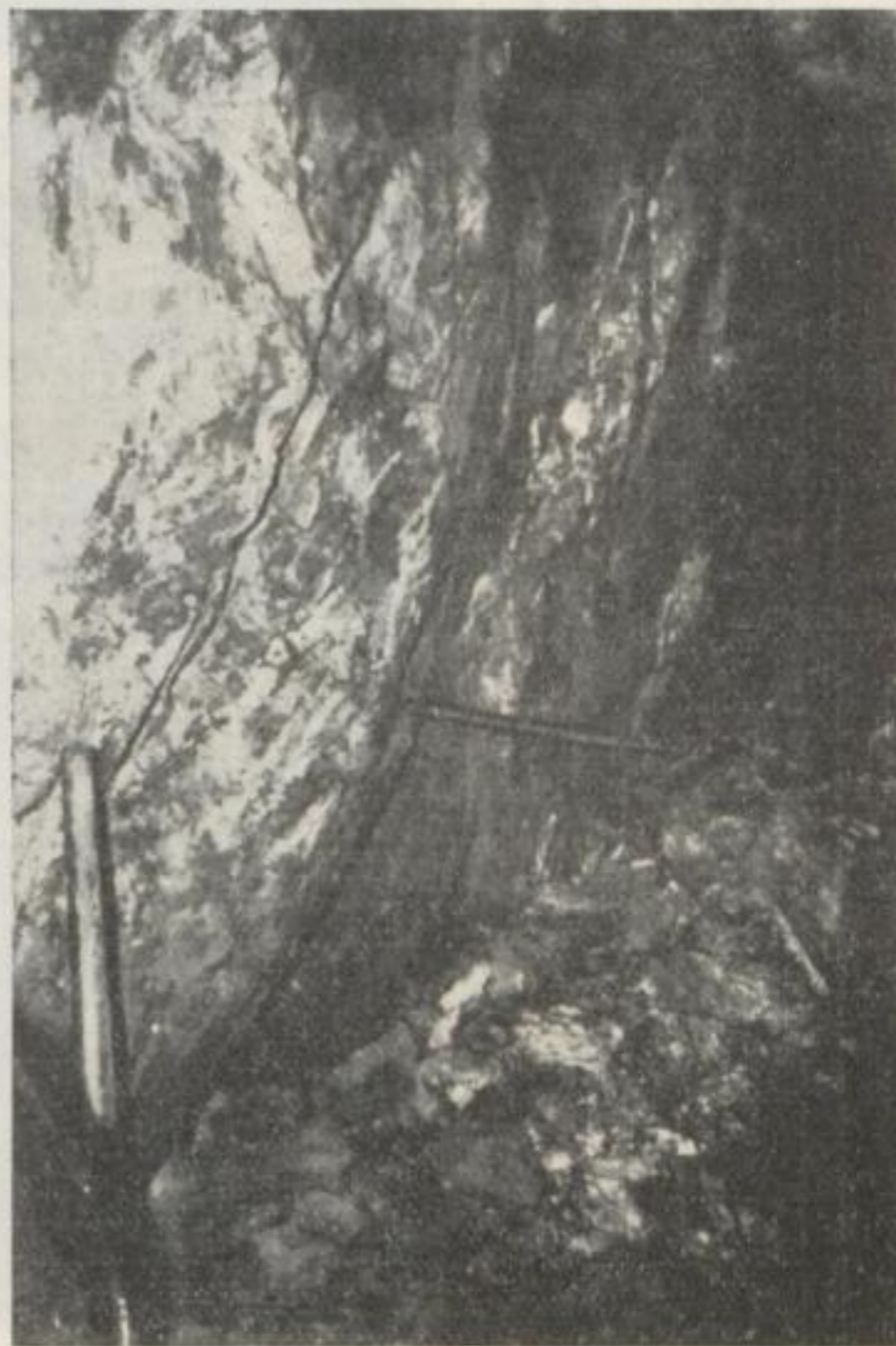
Abb. 16. Halteseil im Magazinbau
