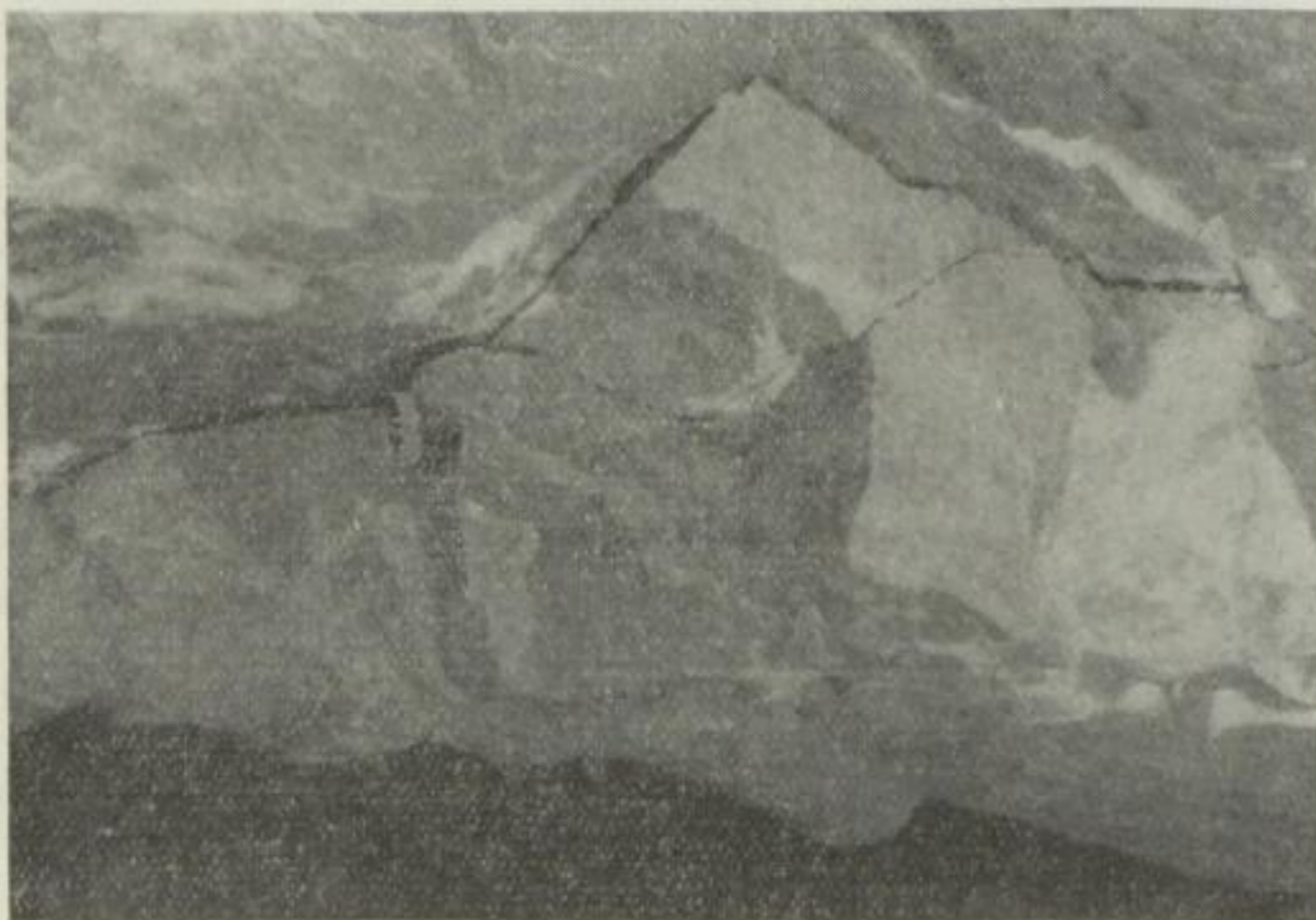
Abb. 13. Ablenbildung an der Unterseite der Schweben im Abbau 232
