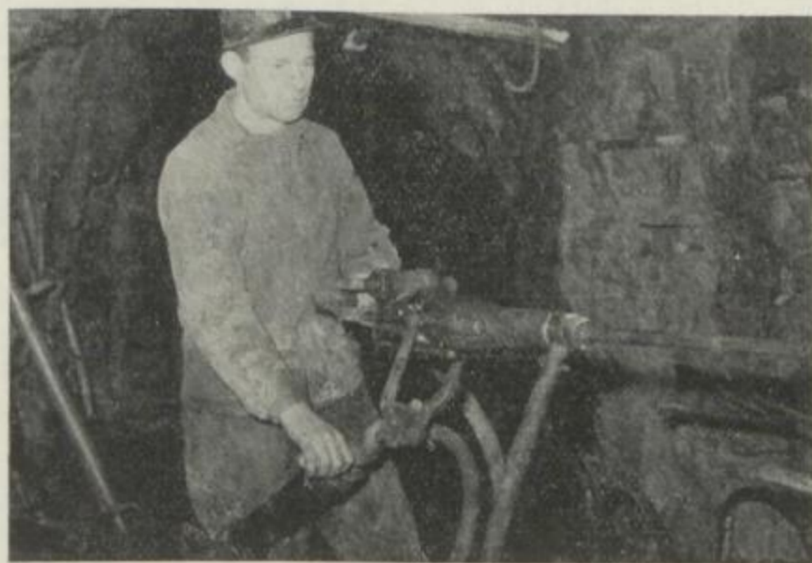
Abb. 1. Bohren von der Bohrstütze aus
