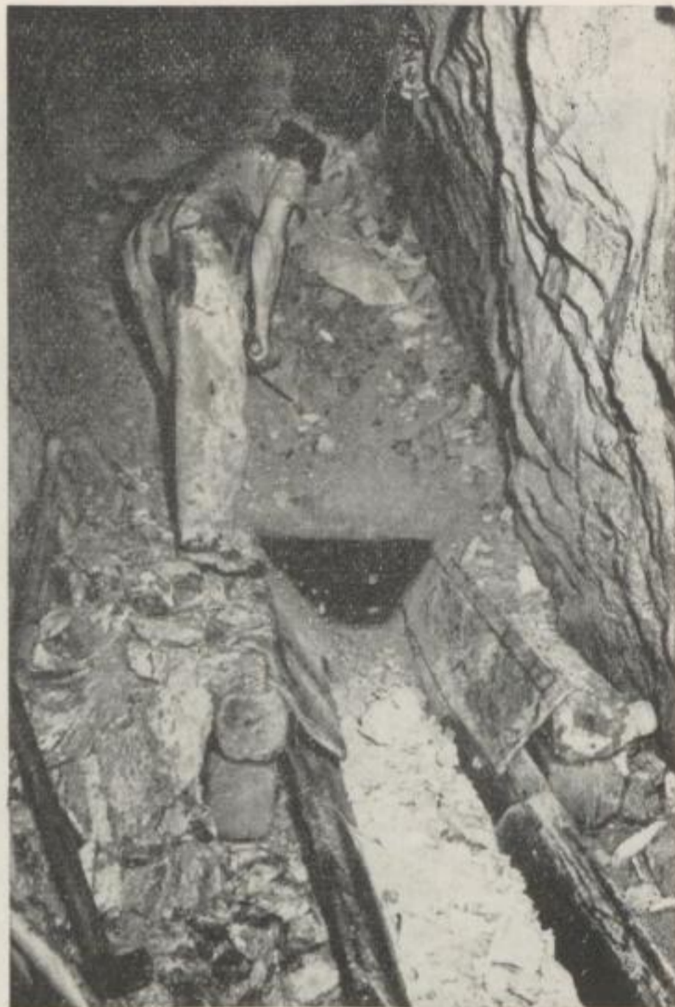
Abb. 9. Schüttelrutsche im Einsatz
