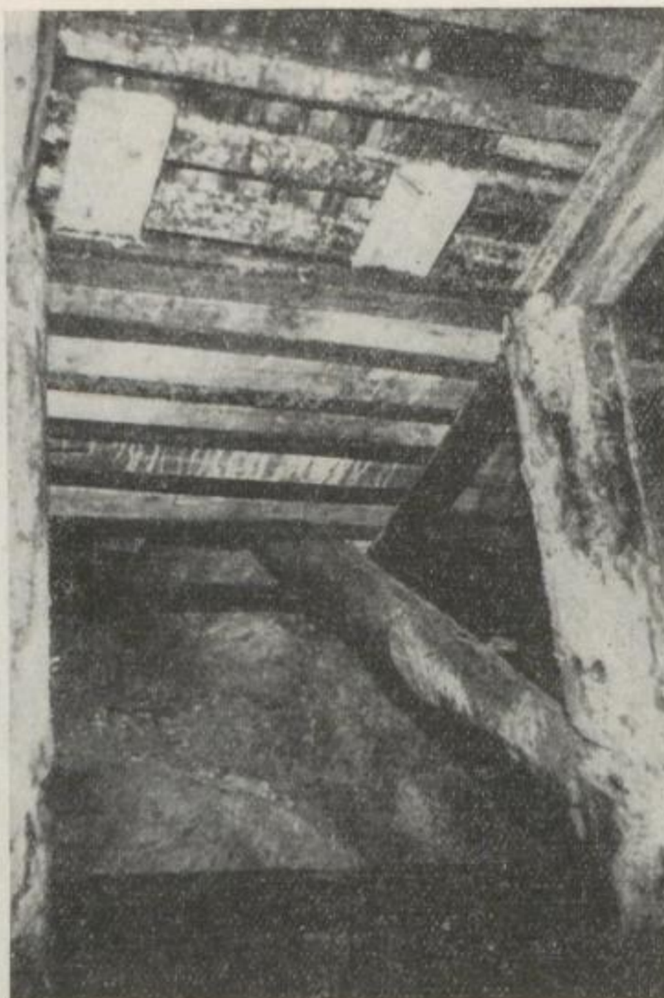
Abb. 17. Rollenverwahrung beim Magazinbau
