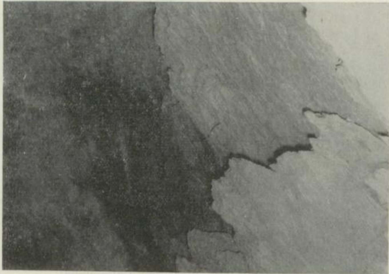
Abb. 30. Ablösen von Schalen über der Grundsohle aus dem Hangenden des Abbaues 221
