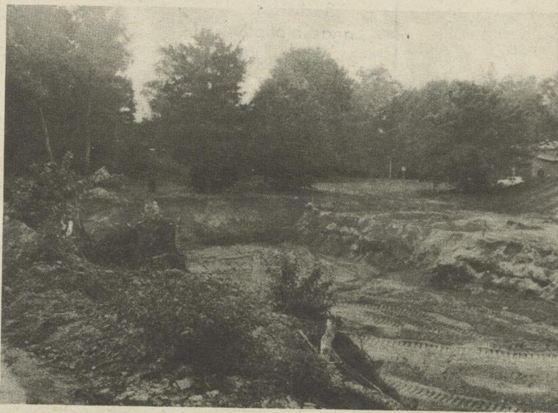
scher Abteilungen. Das rechte Foto entstand im Herbst 1975, als die Baugrube ausgehoben wurde.
