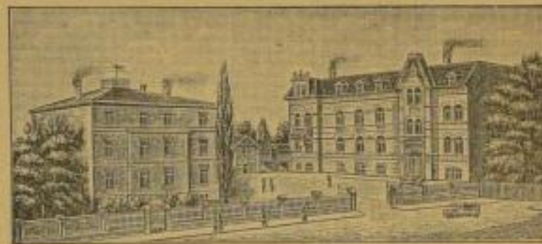
Kontor- und Lagergebäude Schillerweg 34
