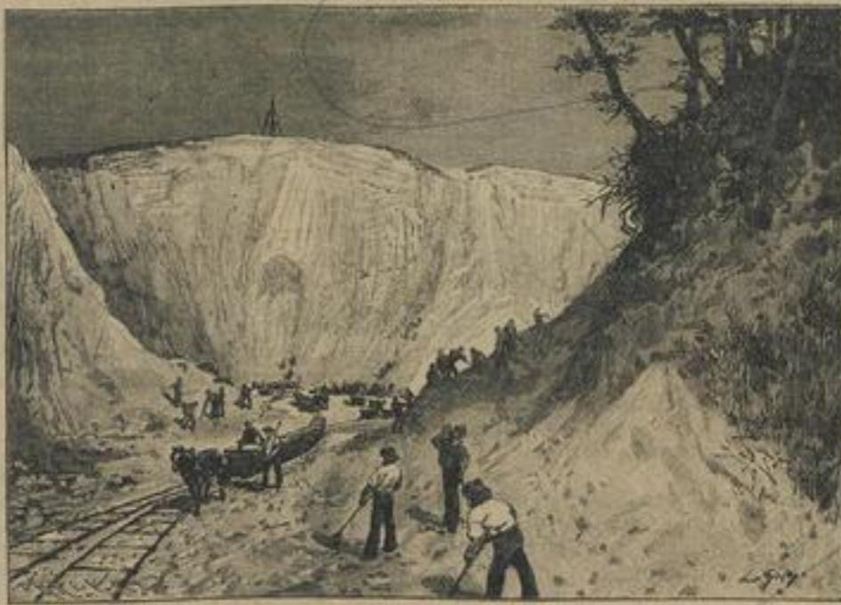
Glick in die Sandgruben des Hofener Berges. (Mark Brandenburg.)
