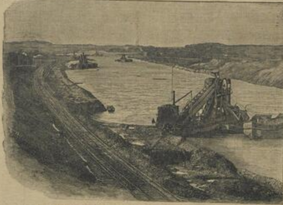
Vom Nord-Elster-Kanal: Durchsicht bei Landwehr (Blick nach Westen).
