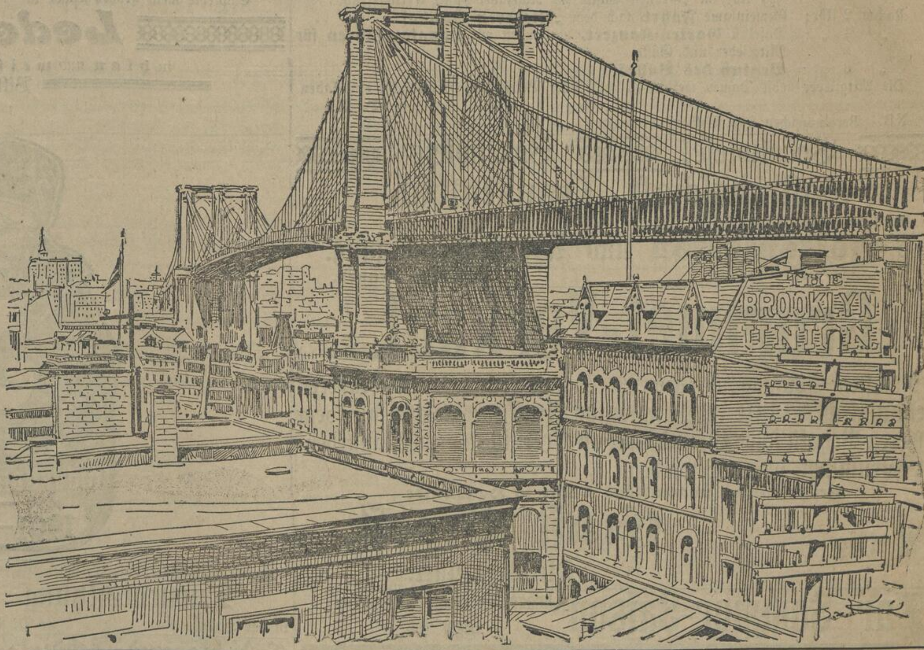
Die Brooklyn Hängebrücke, die sich gegenwärtig hatte und nun wiederhergestellt ist.
