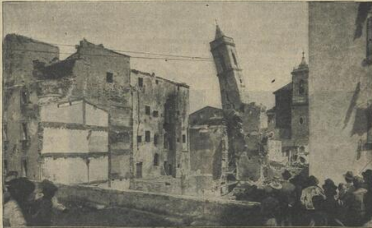
Nach dem Erdbeben in Kalabrien: Niederlegen eines Kirchturms in Tropaei.
