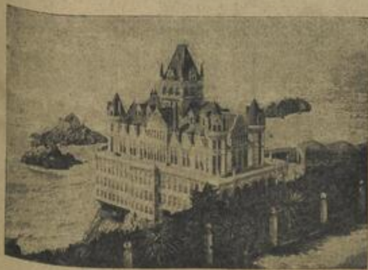
Das beim Erdbeben ins Meer gestürzte Cliff-Haus.
