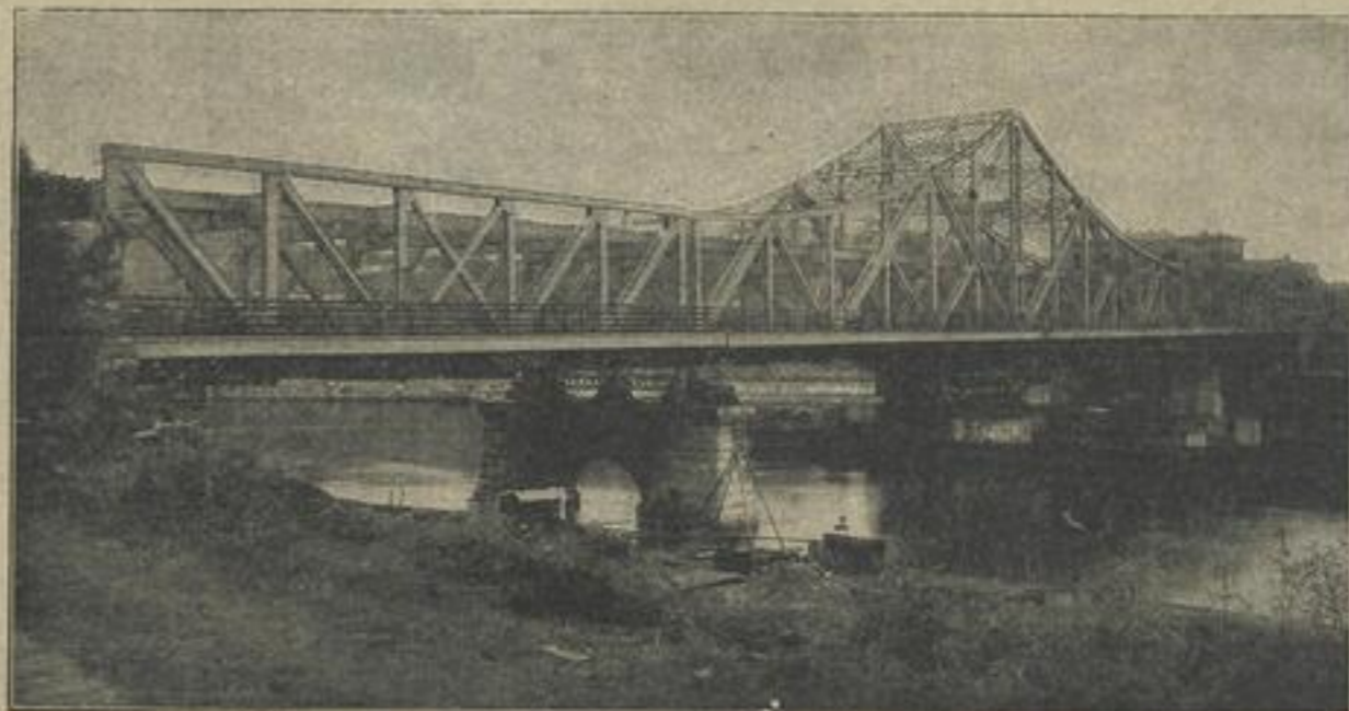
Die große eiserne Drehbrücke über den Harlem-River bei New-York.
