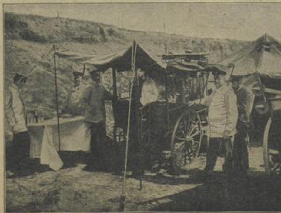
Die fahrbare Küche Kaiser Wilhelms im Manövergelände.
