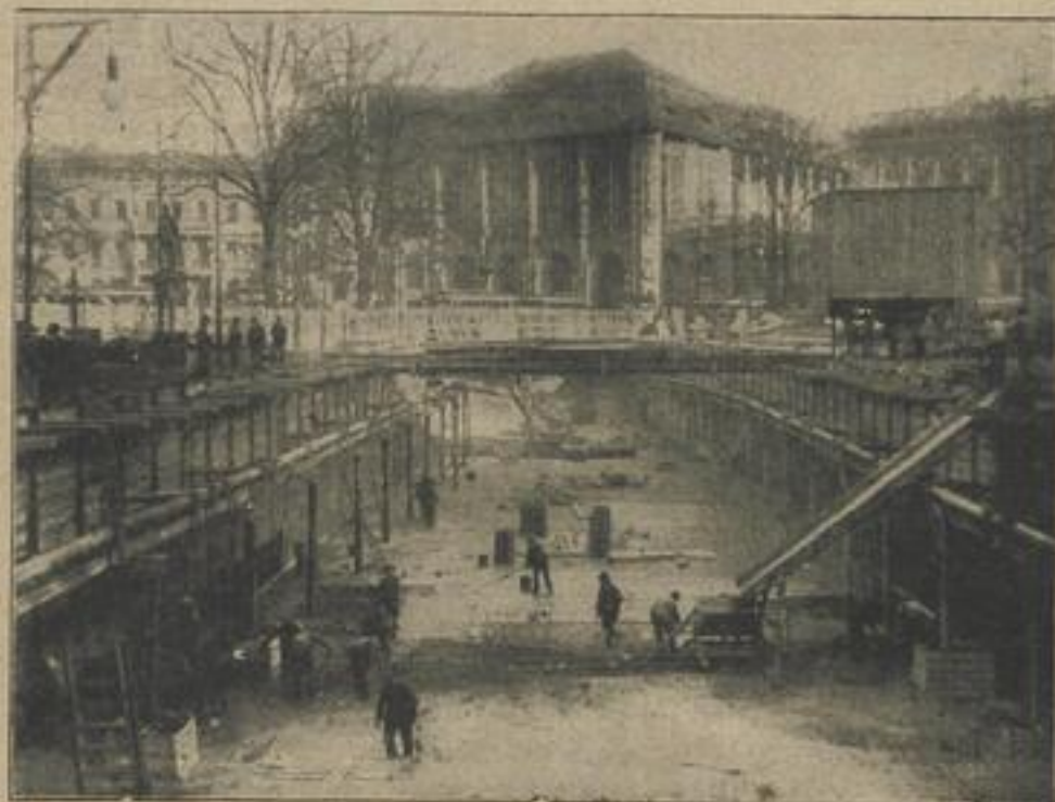
Die Ueberführung der Berliner Straßenbahn über den Bauplatz der neuen Untergrundbahn am Leipziger Platz.
