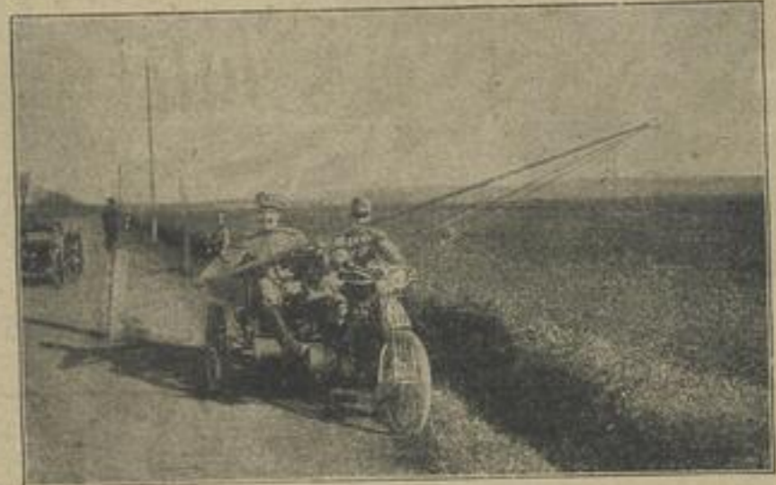
Telegraphen-Motorrad in der Österreichisch-ungarischen Armee: Auslegen des Drahtes mit der Stangengabel in den Straßengraben.
