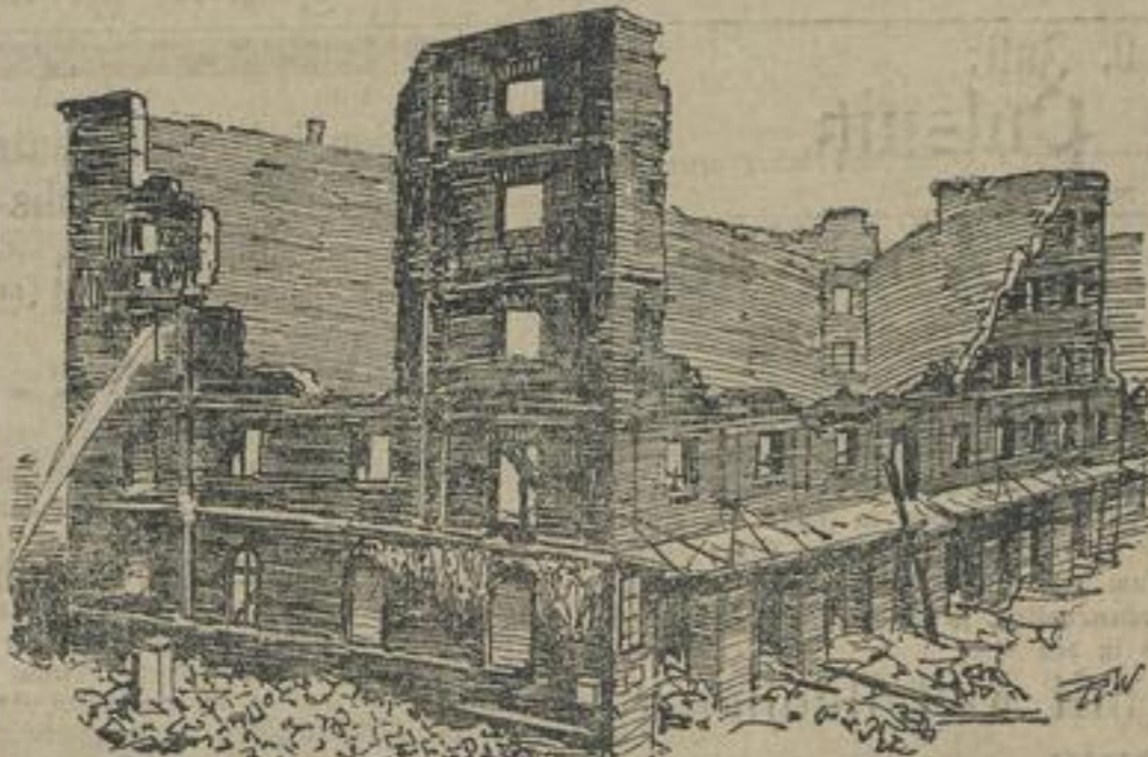
Der Viktoria-Speicher in der Köpenicker Straße zu Berlin ist zum großen Teil ein Raub der Flammen geworden. Nur der äußersten Antrengung der Feuerwehr, die über 24 Stunden arbeitete, ist es zu danken, daß namenloses Unglück verhütet
