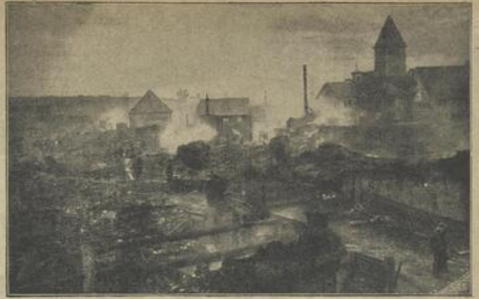
Die Brandstätte in Darnsheim (Württemberg).
