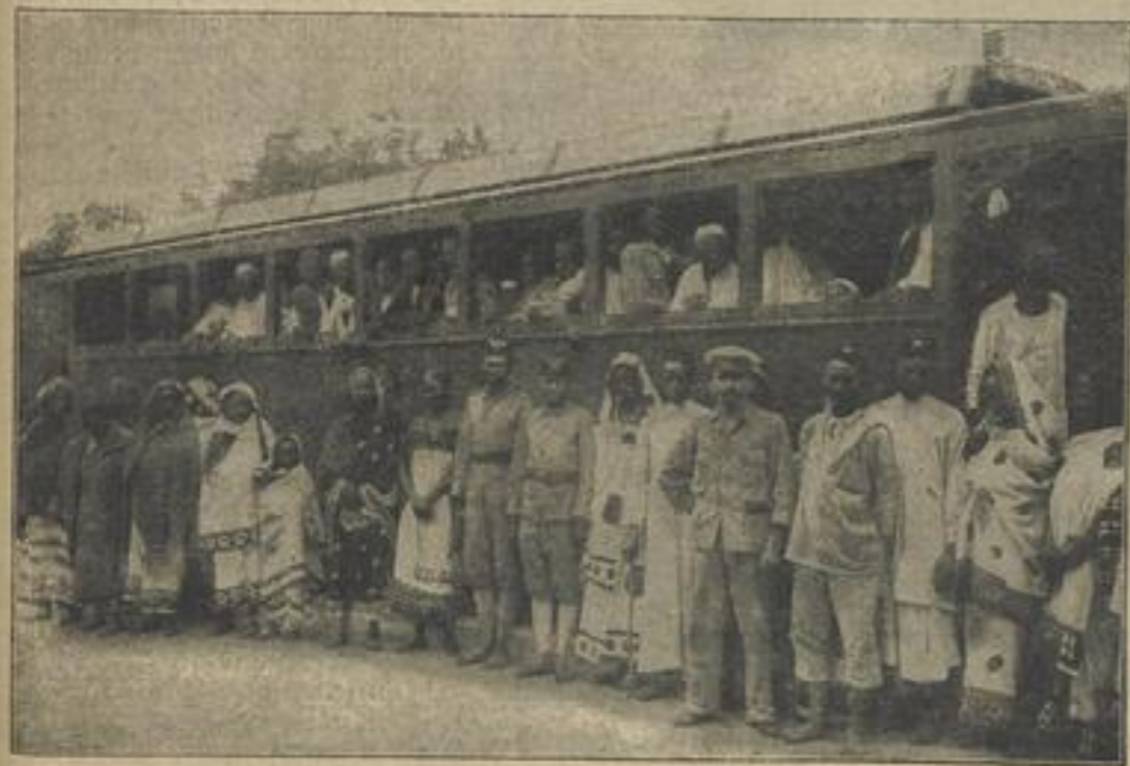
Zur Reise des Kolonial-Staatssekretärs Dernburg: Auf einer Station der Uambara-Bahn.
