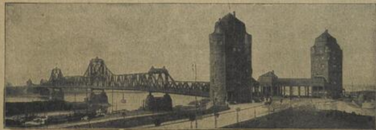
Die neue Rheinbrücke zwischen Ruhrort und Homberg.
