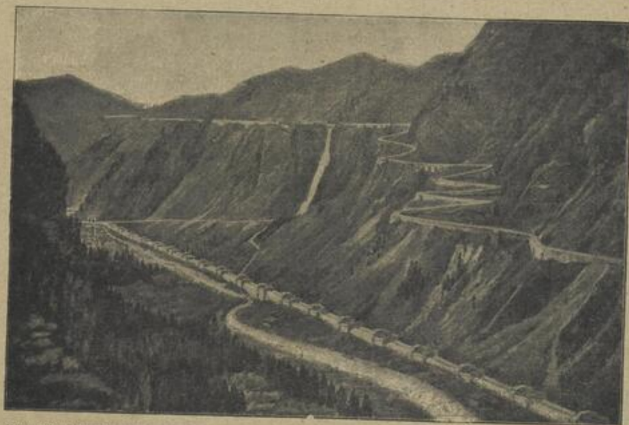
Vom Alpen-Kanalprojekt Caminada: Perspektivische Veranschaulichung eines Stückes der Wasserstraße, bestehend aus zwei Röhren mit entsehbenden Zwischensammelbecken.
