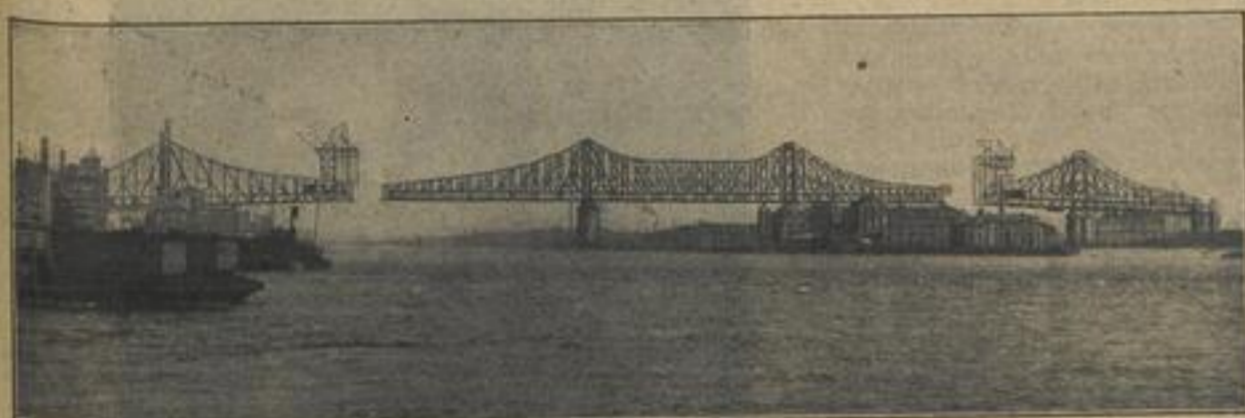
Die neue Blackwells-Insel-Brücke in Newyork vor der Vollendung.
