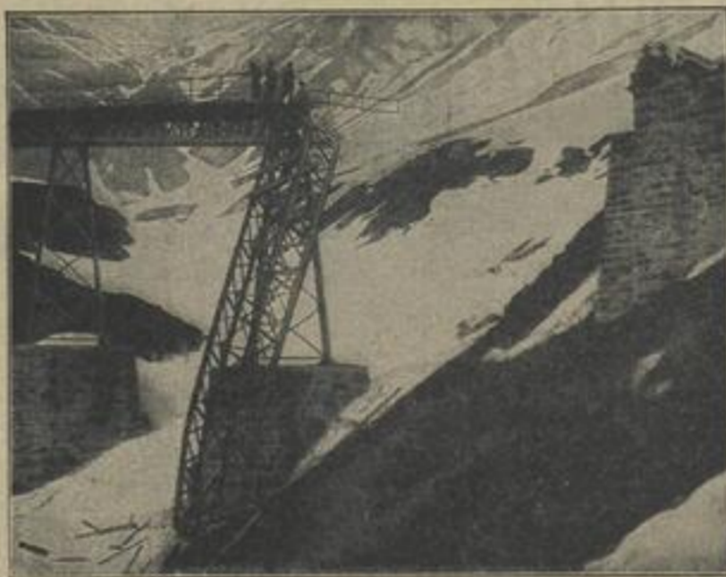
Die durch den Kultdruck einer Lawine zerstörte Mühlebachbrücke im Berner Oberland.
