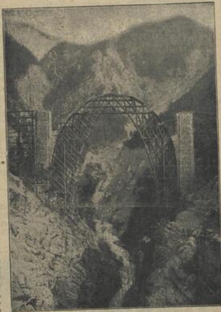
Der Wiesener Viadukt der Bahnlinie Davos-Flimsur.
