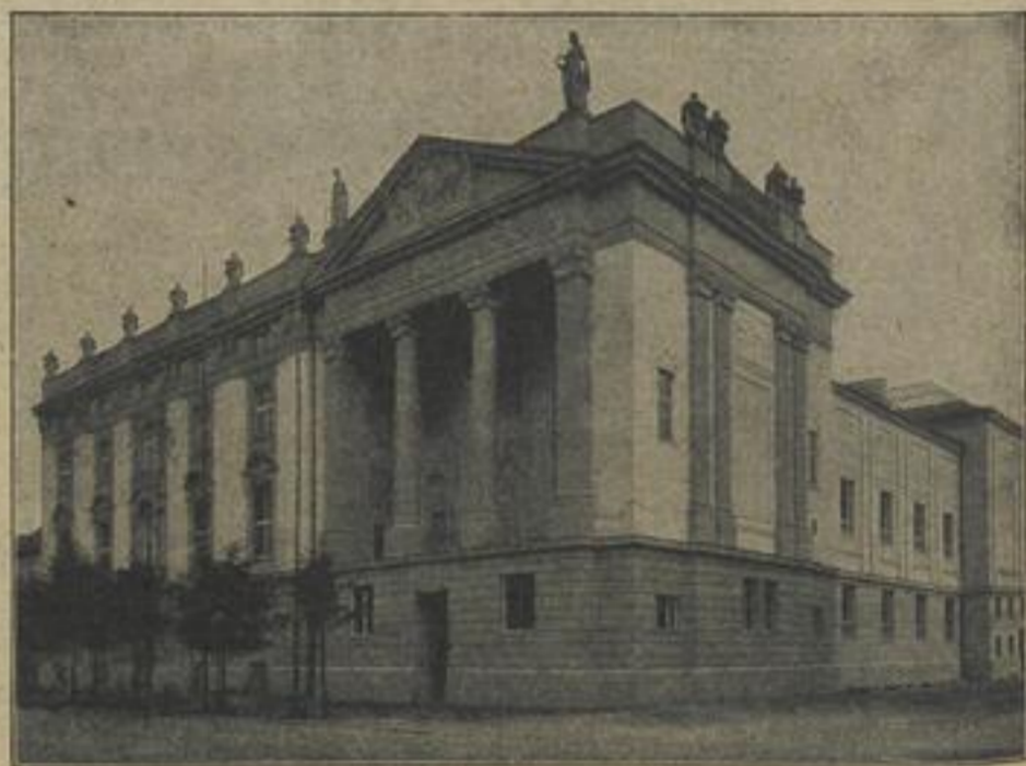
Die neue Schack-Galerie in München mit dem preussischen Gesandtschaftsgebäude.
