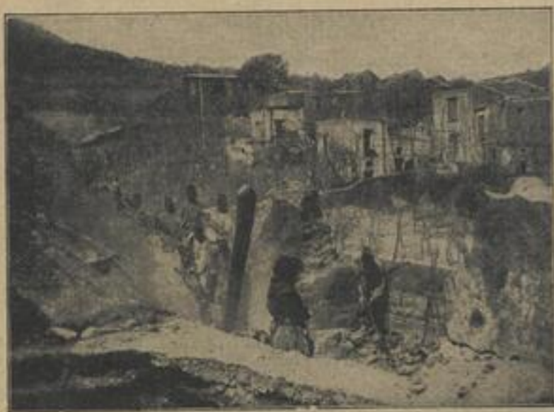
Zu der Erdbeben-Katastrophe in Süd-Italien. Italienisches Militär gräbt in den Trümmern nach Verschütteten.
