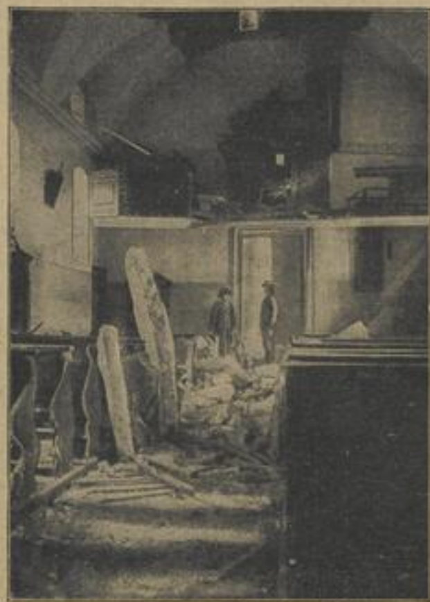
Innere der Kirche von Nax nach dem Einsturz.
