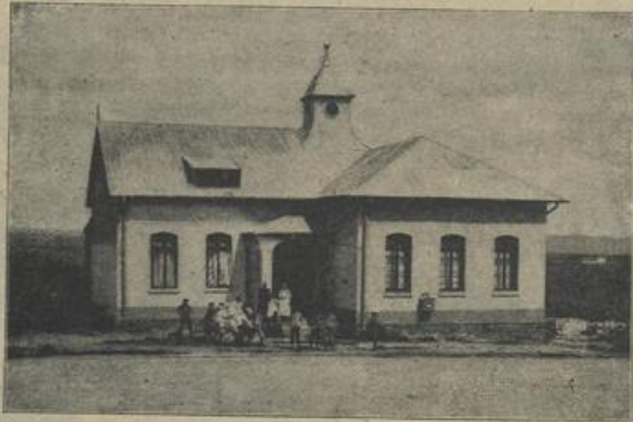
Die neuerbaute Realschule in Windhof in Deutsch-Südwest-Afrika.
