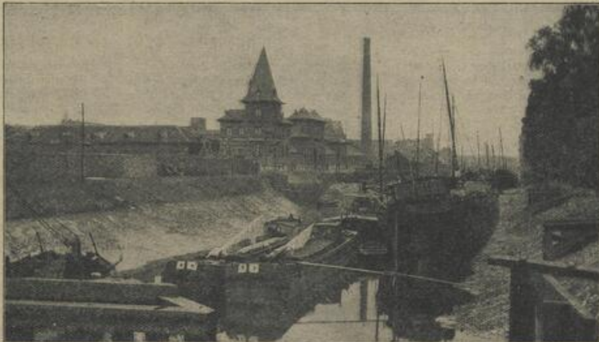
Der durch Dammbruch für Schiffe unpassierbare Canal d'Allée verte.
