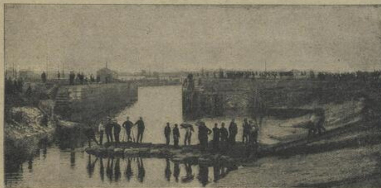
Die Wasserbauarbeiten der Pioniere im Canal d'Allée verte.
