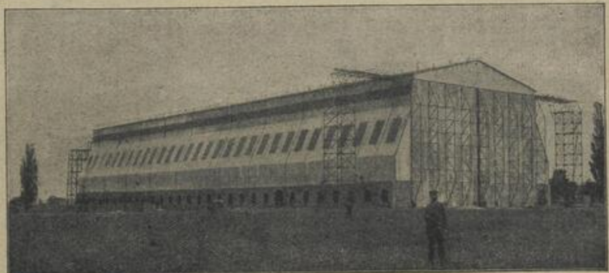
Die neuerbaute Luftschiffhalle auf dem Truppenübungsplatz Frescati bei Meh. Die Luftschiffhalle ist errichtet für das Reichsluftschiff Z 1 in Meh. Der kolossale Bau ist 150 m lang, 60 m breit und 38 m hoch und gibt in seiner Ausdehnung ein Bild von den gewaltigen Dimensionen der Zeppelinischen Flugschiffe. Die mächtigen Eingangstüren laufen auf Rädern und Schienen und öffnen sich leicht beim Herannahen des Luftschiffs. Längs der Halle sind rechts und links die Mannschafts- und Materialräume eingebaut.
