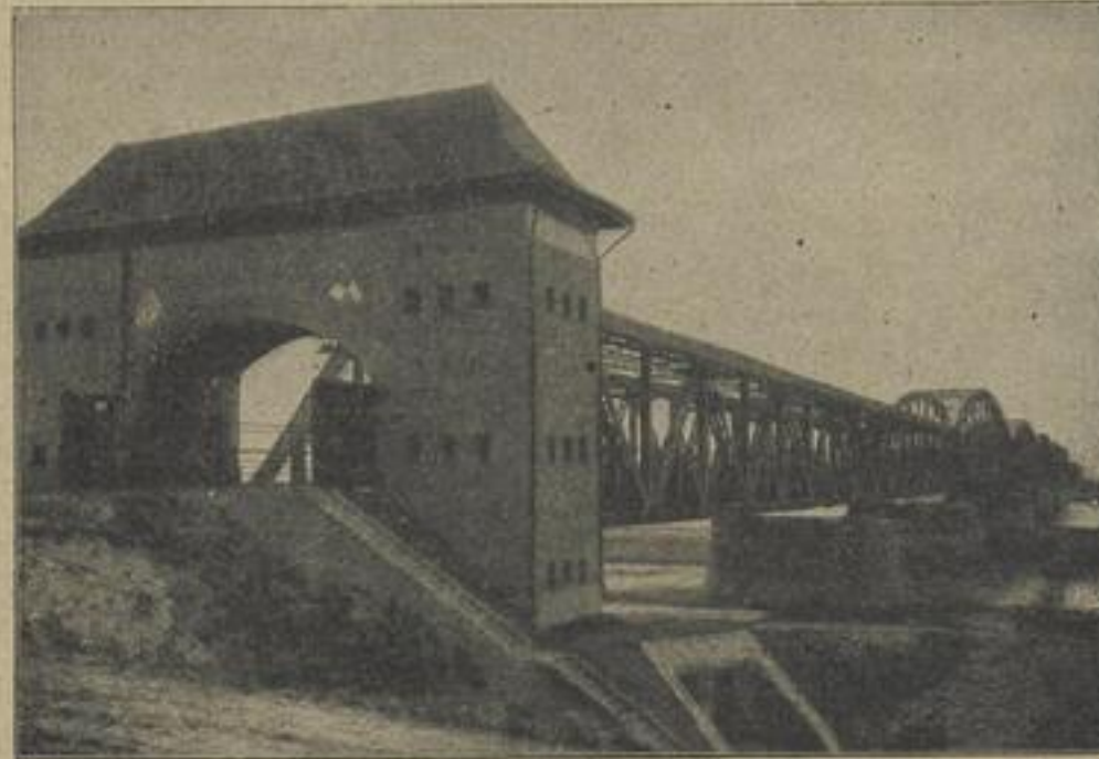
Die fünfte Weichsel-Eisenbahnbrücke bei Marienwerder
