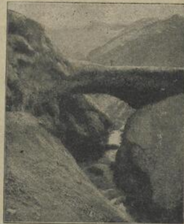
Die Inka-Brücke auf der argentinischen Seite, in deren Nähe die Ueberlandbahn vorbeigeleitet wird.
