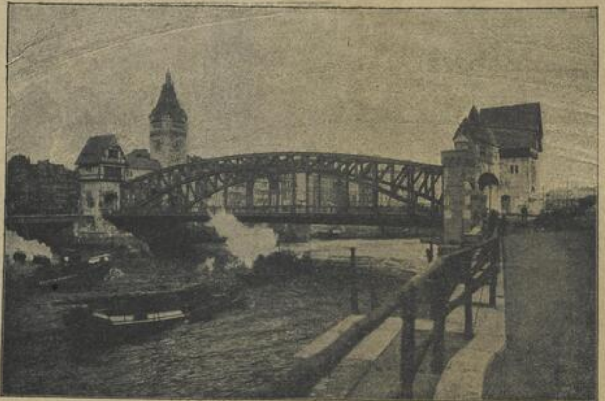
Die neue Brücke am Neuhof in Hamburg, die das Freihafengebiet mit der Stadt verbindet.
