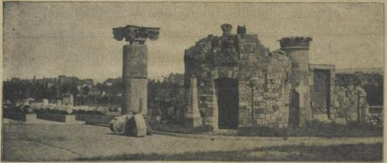
Verwitterungsprüfung von künstlichen und natürlichen Steinen in der kgl. preussischen Materialprüfungsanstalt in Dahlen bei Berlin.
