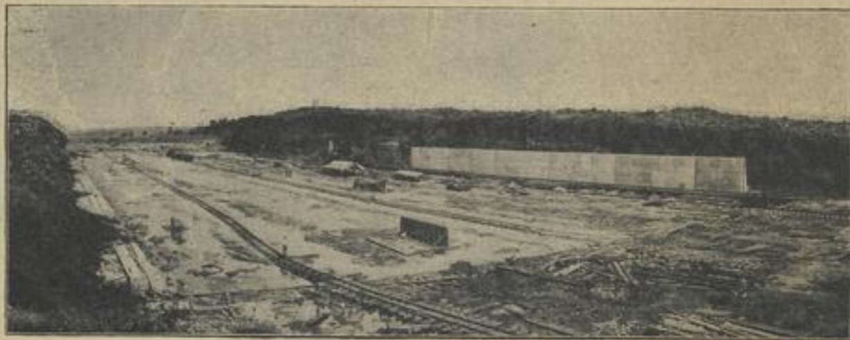
2. An der Mündungsstelle des Panamakanals in den Stillen Ozean. Eine der mächtigen 60 Fuß hohen Betontwände für die Schleusenanlagen.
