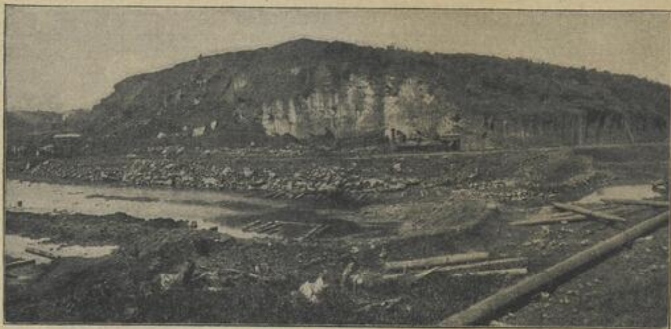
3. Ausbaggerungsarbeiten bei Gatun, der Mündung des Panamakanals in den Stillen Ozean. Durchscheidung mäch- tiger Felsenwände, Auffangung eindringender Wasser des Chagresflusses in das Kanalbett durch große Saugpumpwerke.
