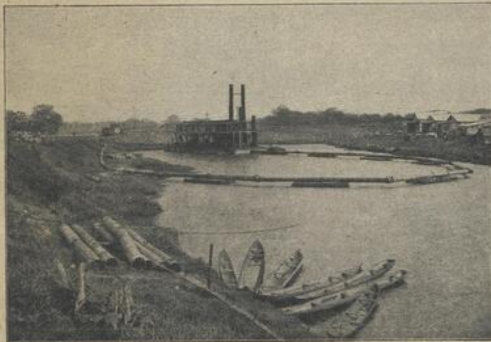
Vom Biejenbau des Panamakanals: 1. Saugbaggeranlagen am Chagresfluß.
