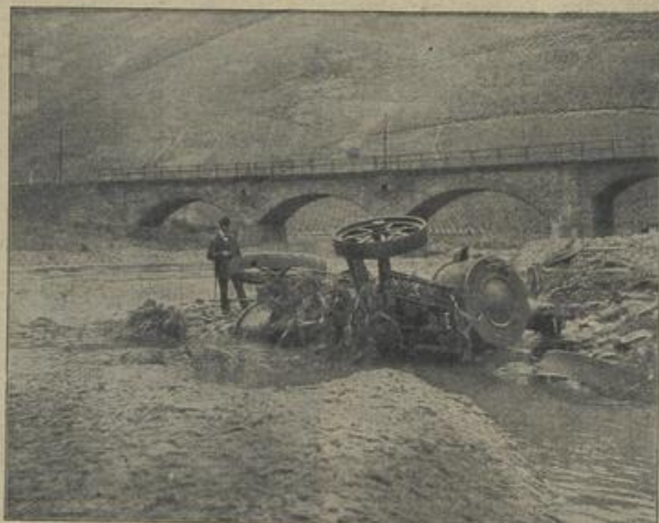
Zur Hochwasserkatastrophe im Ahrtal: Trümmer vom Bau der fast vollständig zerstörten Ahrtalbahn.
