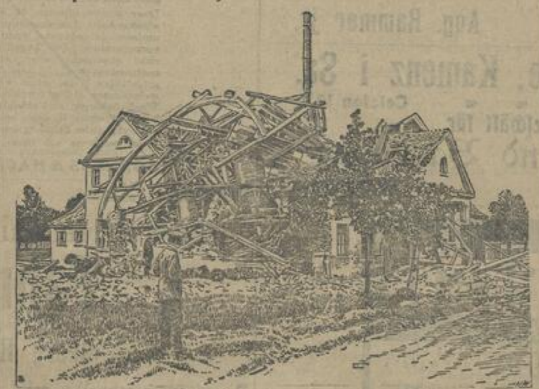
Eine furchterliche Explosion hat am 19. Juli die Karboniumfabrik in Friedrichshafen vernichtet. Die große Fabrikanlage hatte die Aufgabe, Acetylen durch elektrische Zündung in reines Kohlenstoff- und Wasserstoffgas zu zerlegen; das Wasserstoffgas wurde dann in den großen Gasometer der Zepelin-Luftschiffbauanstalt geliefert und zur Füllung der Zepelin-Ballons verwendet. Die Explosion entstand
