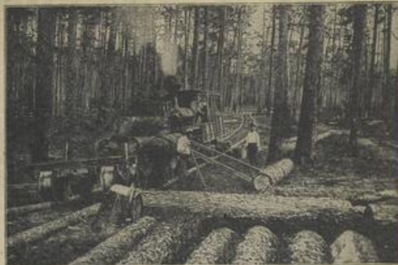
Holzabfuhrbahn in den nordamerikanischen Waldgebieten; die Bahn läuft auf primitiven Schienen, die aus toten Baumstämmen gebildet sind. Die Lokomotive wird mit Holz geheizt.
