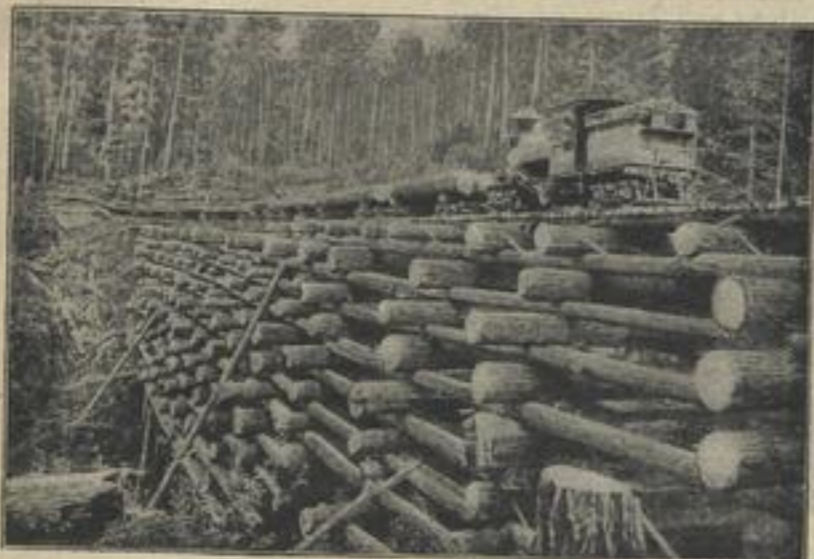
Aus den nordamerikanischen Waldbrandgebieten: Primitiver Brückenbau auf einer Holzbeförderungsbahnstrecke. Die gewaltigen Waldbrände in Nordamerika, denen Wälder im Wert von 50 Millionen Mark, ferner acht Städte, zahlreiche Ortschaften und Hunderte von Menschen zum Opfer fielen, haben wieder einmal die Aufmerksamkeit auf die unermesslichen Naturreichtümer der nordamerikanischen Holzreviere gelenkt und auf den unverantwortlichen Verschleiß, durch den dort alljährlich riesige Waldstrecken durch Feuer vernichtet werden. Wäre eine geregelte Forstwirtschaft eingeführt, könnte ein Brand nicht allzu weit greifen, da er in den eingespreuten Laubholzbeständen und Schneisen Widerstand fände.
