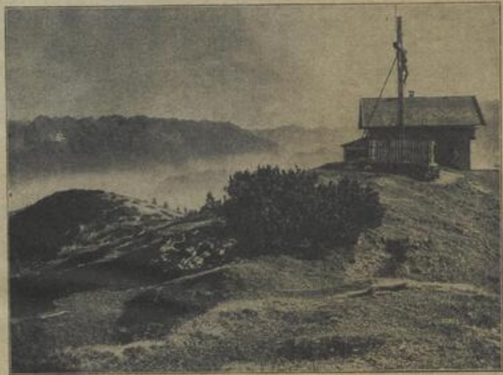
Eine neue Schutzhütte in Oberbayern.
