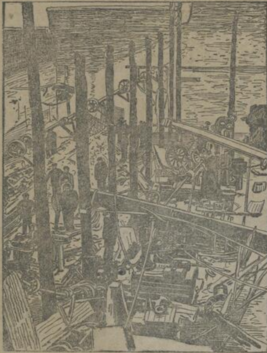
Ein große Schiffbauwerk in Cowes (England). In der vor allem Jachten und Torpedoboosterfabrik erbaut werden, geriet dieser Tag in Brand. Der Wärschuppen und andre Teile des Fabrikgebäudes wurden eingestürzt. Mit Mühe und Not gelang es,
