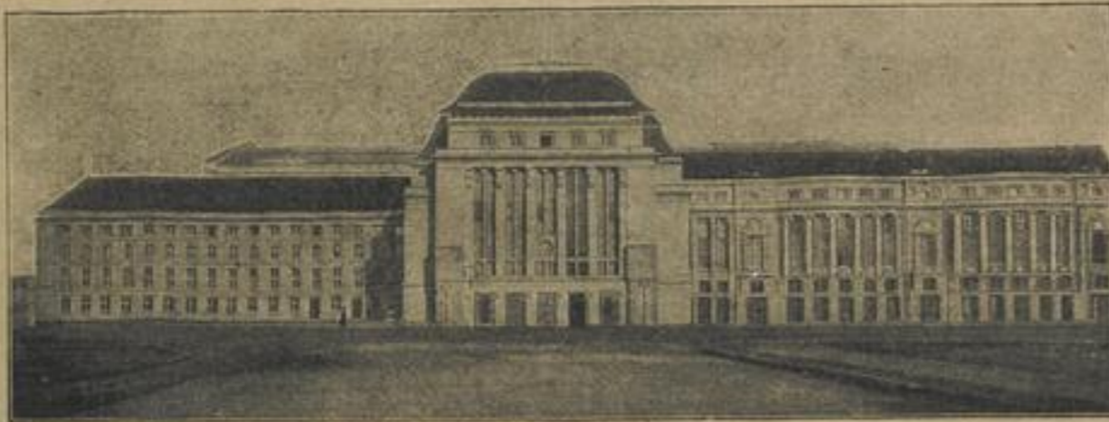
Der Neubau des Leipziger Hauptbahnhofs, des größten Bahnhofs Europas. Unsere Abbildung zeigt den Westflügel des Bahnhofsgebäudes, der jetzt im Rohbau fertiggestellt ist; an der Inneneinrichtung wird eifrig gearbeitet. Die Front des gesamten Bahnhofs, der nach dem preisgekrönten Entwurf von Löffow & Kühnel erbaut wird, wird mehr als die doppelte Länge des jetzt fertiggestellten Flügels erhalten. Die Westhälfte soll im Mai 1912, der gesamte Bau im Jahr 1915 eröffnet werden. Die Kosten der Bahnhofsanlagen betragen 68 Millionen Mark, die der gesamten Bahnbauten weit über 100 Millionen Mark.
