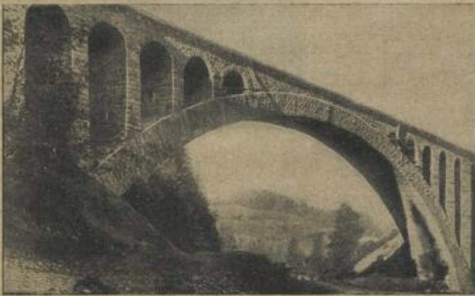
Die größte Steinbrücke der Schweiz
