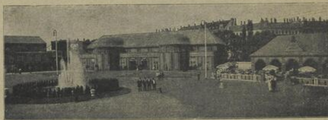
Von der Elektrotechnischen Ausstellung in Leipzig: Der Hauptplatz mit der Fachausstellung und der elektrischen Leuchtfantäne. Rechts Café und Konditorei.
