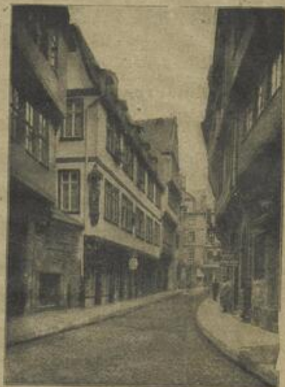
Die Straße „Hinter dem Lämmchen“ in Frankfurt a. M.
