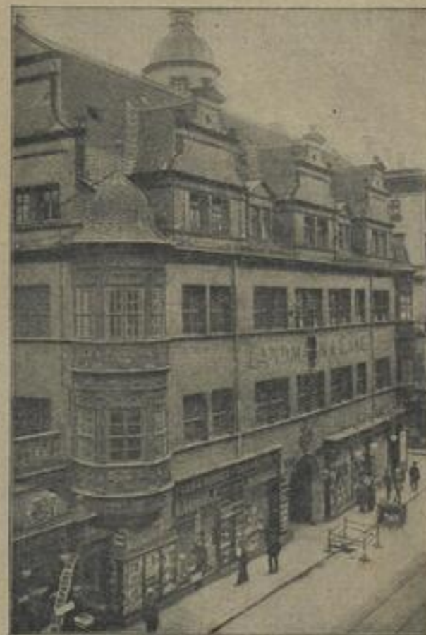
Das Leipziger Fürstehaus, einer der ältesten und schönsten Renaissancebauten der Stadt, wird umgebaut, um neue Räume für eine Geschäftsfirma zu schaffen. Das Fürstehaus ist Eigentum der Universität; es wurde 1558 erbaut und war früher Professorenwohnung. Da der Umbau durch eine
