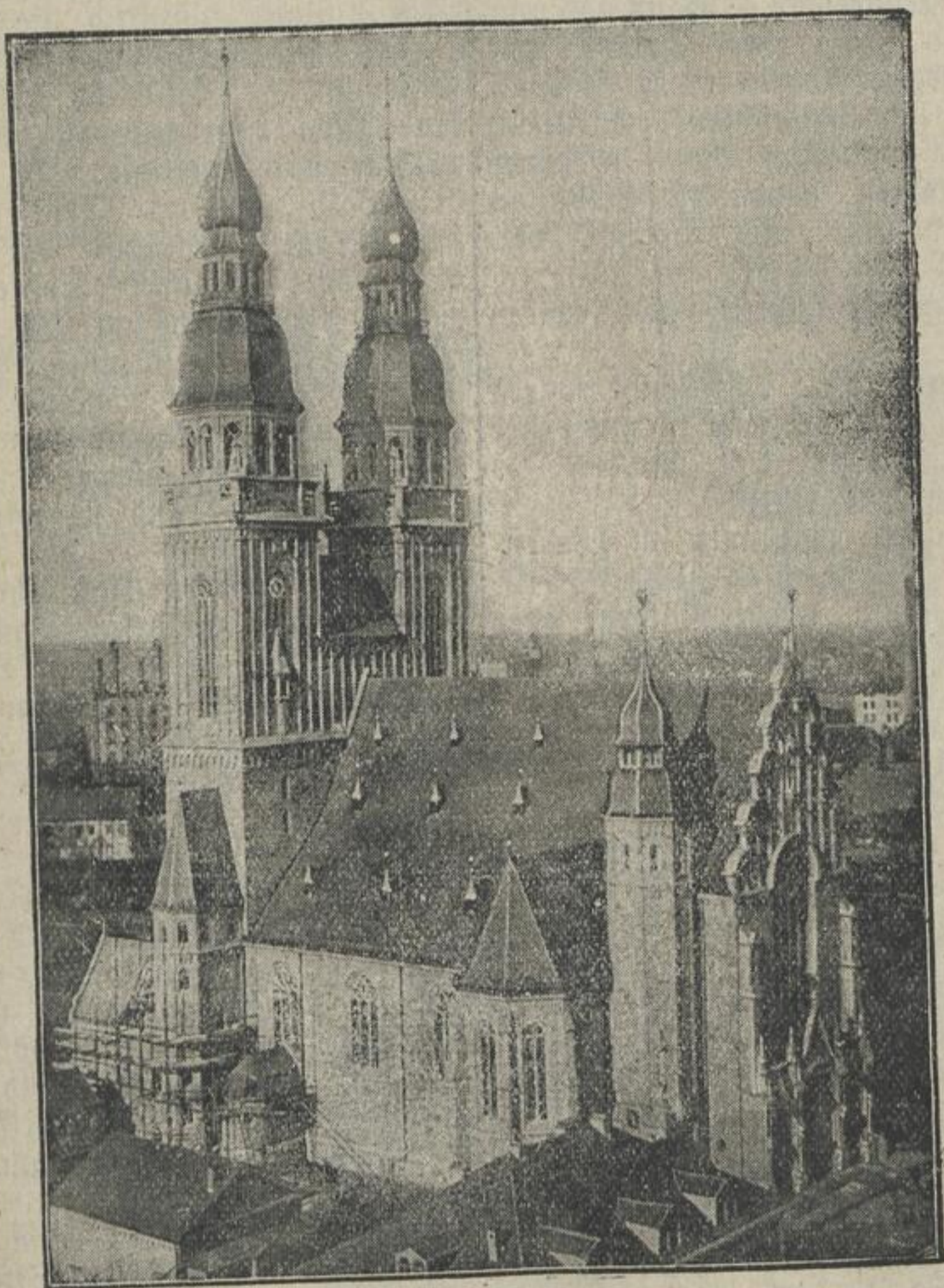
Die neue St. Josephskirche in Speyer, die nach den Plänen des Prof. L. Becker, Mainz, erbaut wurde, geht sehr ihrer Vollendung entgegen. Wir zeigen hier die monumentale neue Kirche.
