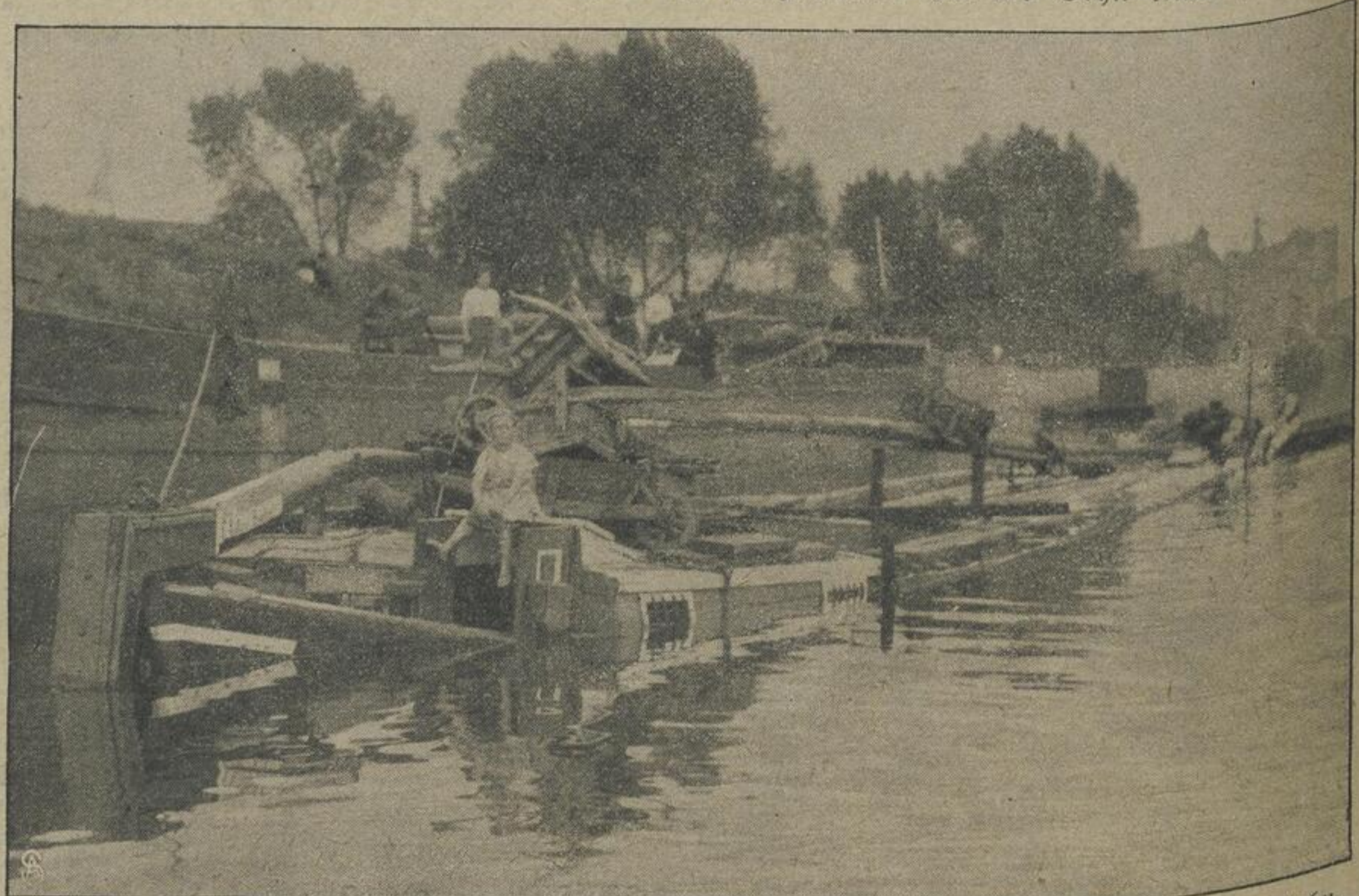
Ein Schiffsunfall auf der Spree. Der am Habsburger Ufer in Charlottenburg gesunkene Kahn.
