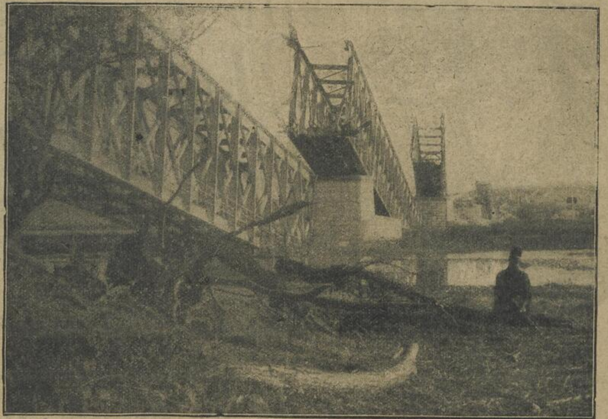
Die berühmte Eisenbahnbrücke Semlin—Belgrad, die die Serben bei ihrem Rückzug zerstörten. Die aufstrebenden Teile der Brücke sind durch österreichisch-ungarische Truppen von den Pfeilern weggeräumt worden und über die unbeschädigten Pfeiler ist eine neue Eisenbahnbrücke gebaut.
