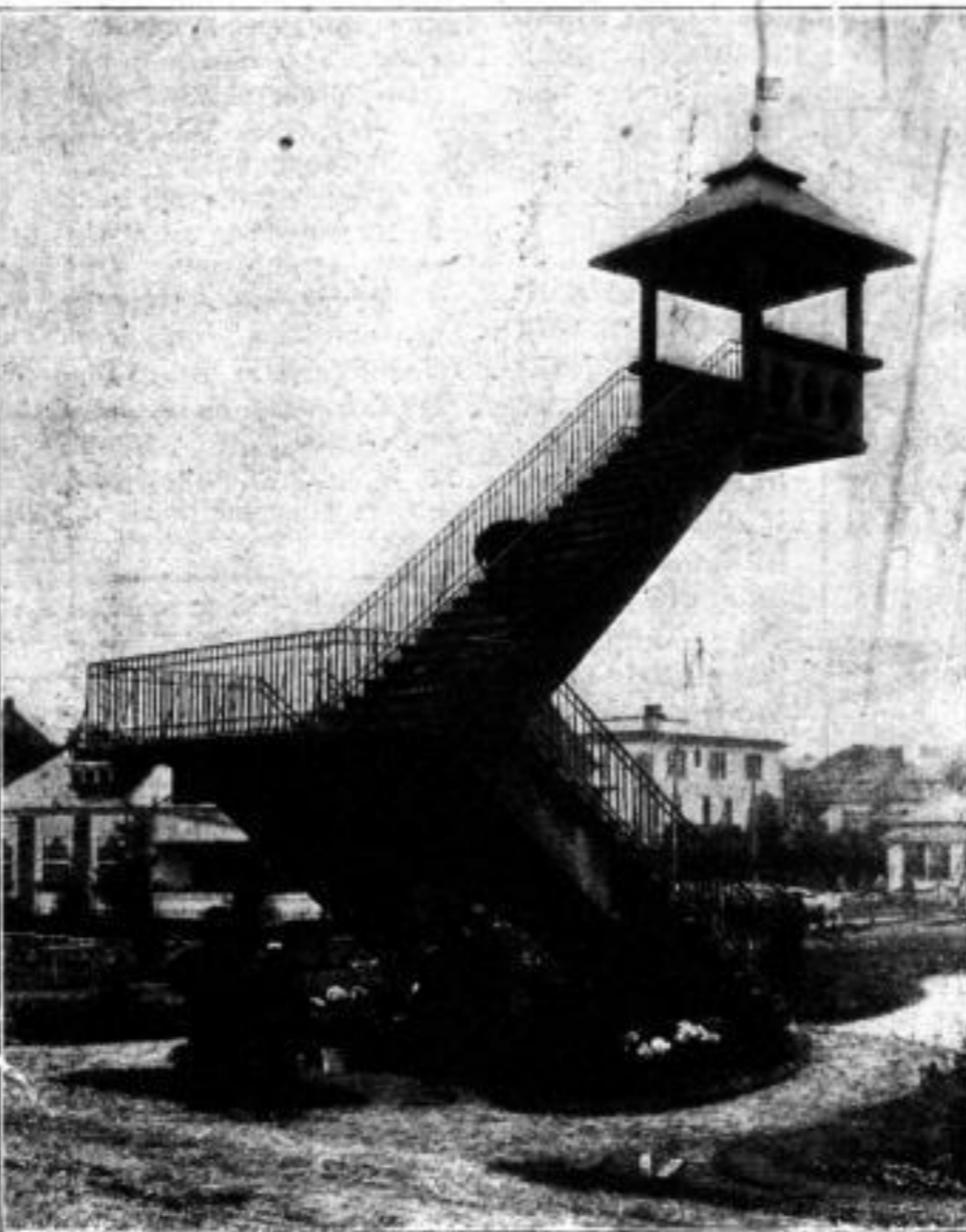
Eine schwebende Treppe. (Mit Text.)
