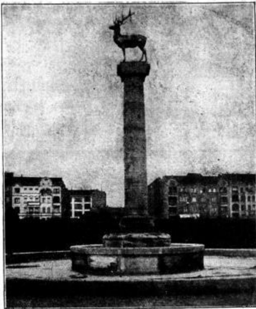
Neuer Monumentalbrunnen im Stadtpark Schöneberg. Phot. H. Fuchs, Berlin-Wilmersdorf. (Mit Text.)
